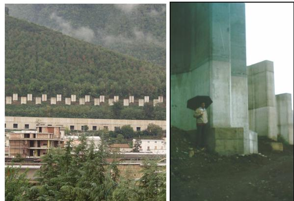
Fig. 3.26: Speroni in calcestruzzo armato realizzati sul versante del Comune di Pagani (SA)
