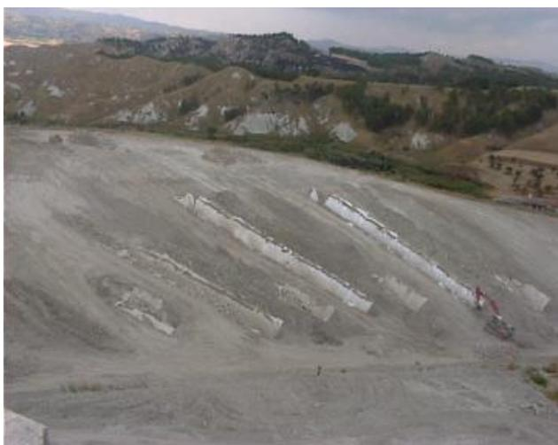
Fig. 4.10: Esecuzione del modellamento dei versanti con posa in opera delle trincee drenanti
