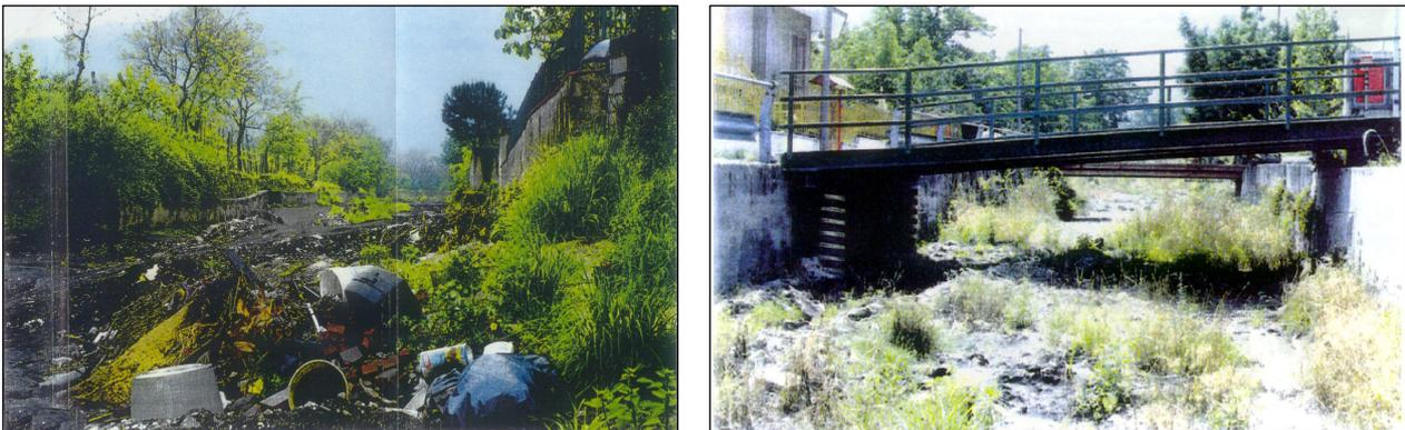
*Fig. 5.4: Esempi di degrado della rete di canali esterna ai territori dei cinque Comuni (da Cascini, 2003a).*
