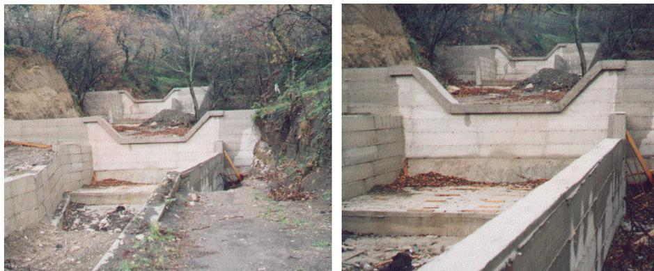
Fig. 5.8: Briglie realizzate lungo gli impluvi di alcuni bacini del Comune di Quindici.
