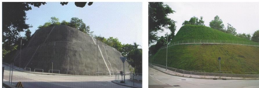
Fig. 3.14: Rilevato artificiale nel territorio di Hong Kong stabilizzato con l'impiego di soil nails (da GEO, 2003; modificata).
